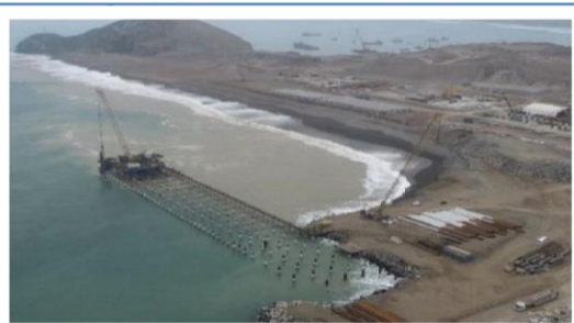
Hincado de pilotes – Muelles 1, 3 y 4
