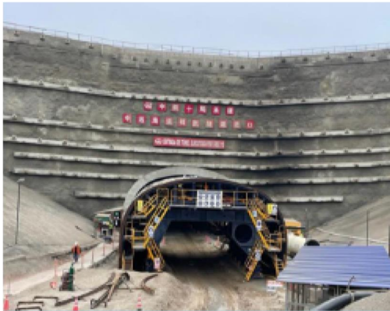
Portal del túnel – Complejo de ingreso
