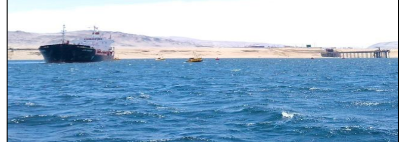
Terminal Portuario – MINA JUSTA
