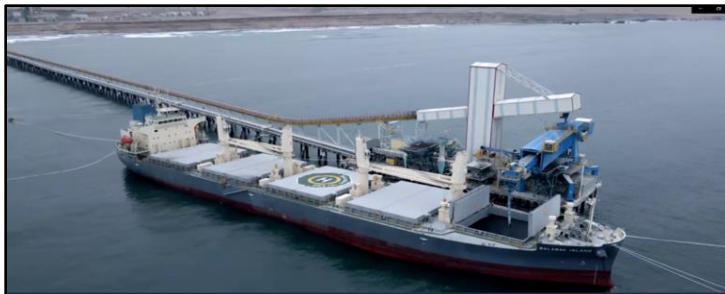
Terminal Portuario – ENGIE
