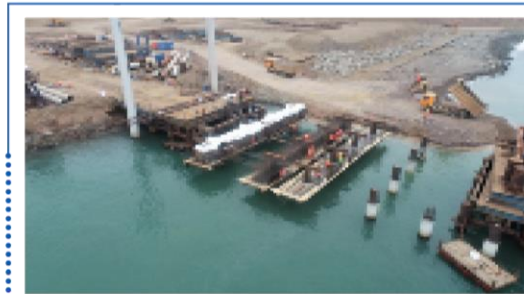
Hincado de pilotes – Muelles 1, 3 y 4
