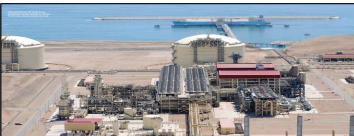
Terminal Portuario – MELCHORITA PERU LNG
