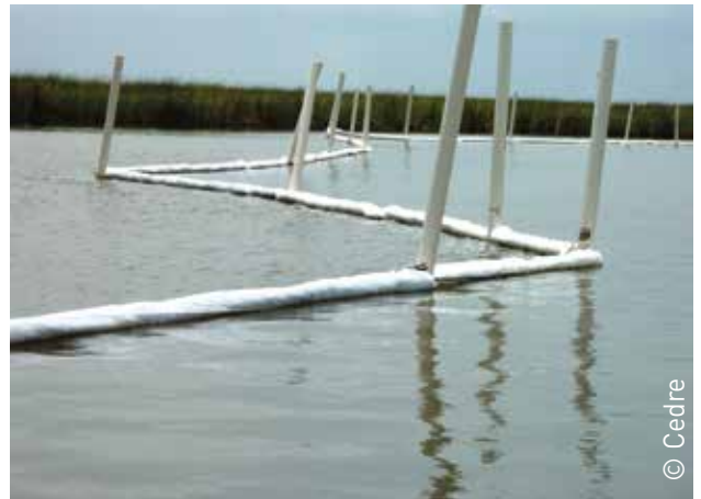
Configuración en espiga (en cada orilla del río)
