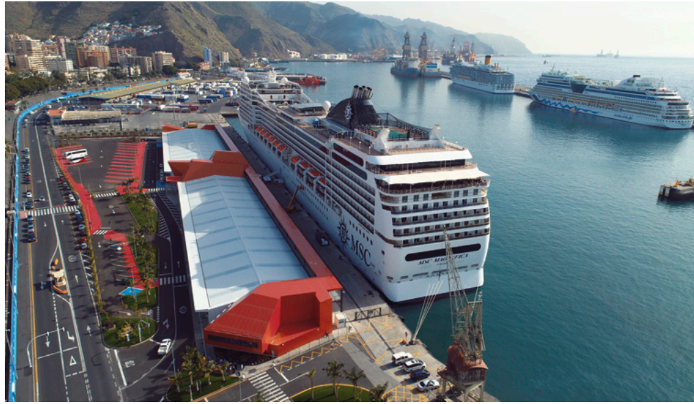
Terminal de cruceros del Puerto de Santa Cruz de Tenerife.
