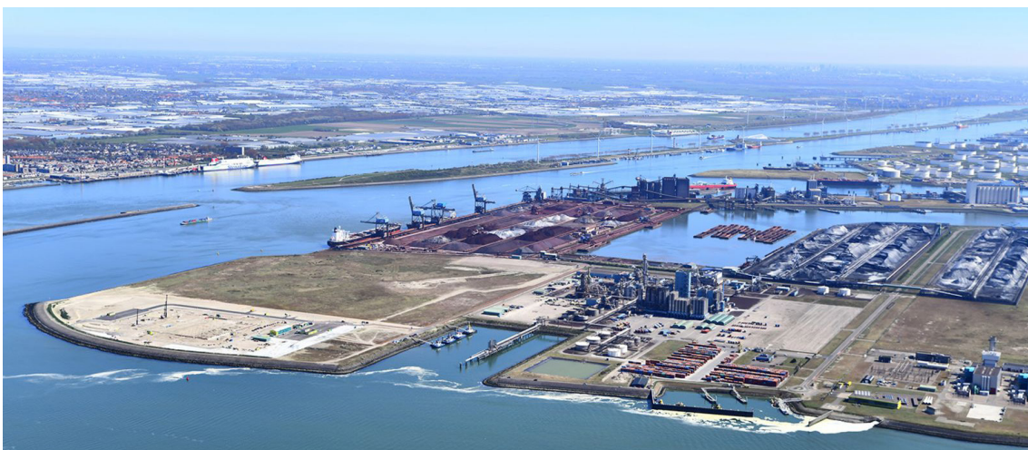
Emplazamiento del puerto Kop van de Beer, Europoort. Danny Cornelissen. © Puerto de Rotterdam
