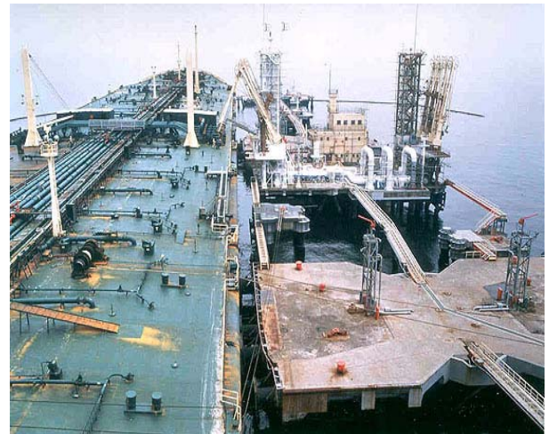
Figura 23. Atraque de un petrolero a un pantalán. Se observan los brazos de carga acoplados al manifold.
