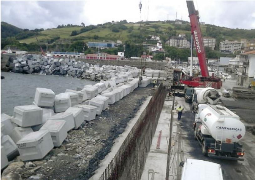
La obra, es convencional, si dejamos al margen las circunstancias excepcionales ya comentadas en el arranque de la misma, por ello me gustaría incidir en principal novedad que introduce, que no es otra que la utilización de hormigón de alta densidad como material para la fabricación de los bloques del manto principal.
