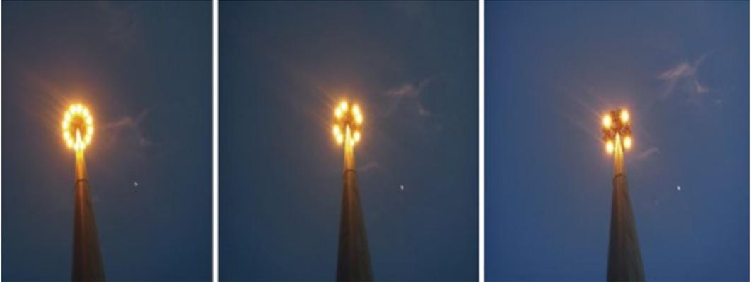
**Figura 4. Modos de funcionamiento de la torres de alumbrado: 100% - 66% - 33%**
