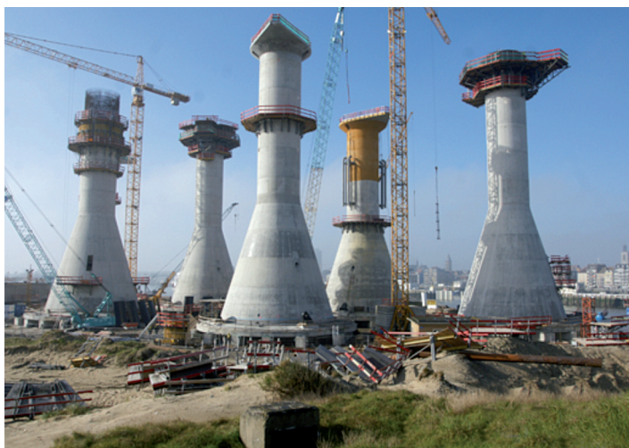
Figura 4. Subestructura GBS (cajones) en construcción para el proyecto Thornton Bank-fase I.
