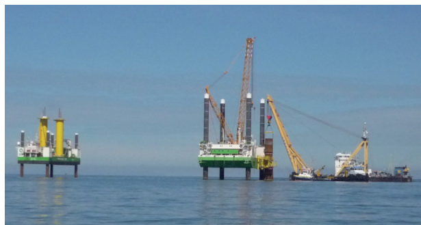
Figura 10. Equipo de Geo Sea N.V. durante la instalación de las subestructuras.
