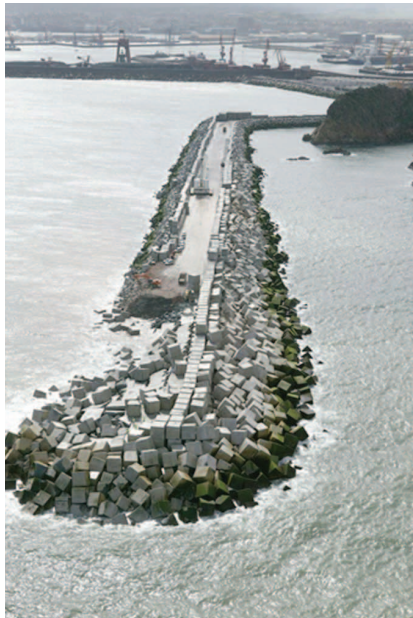
Figura 14. Avería taludes interiores.
