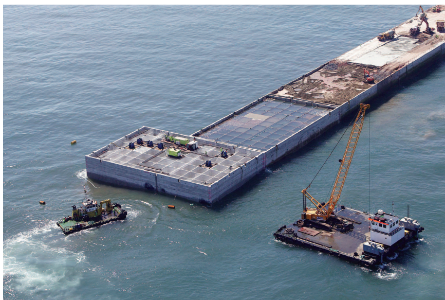
Figura 10. Fondeo Cajón n.º 19.
