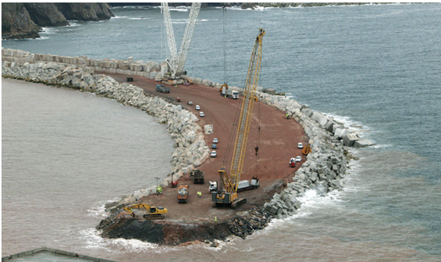
Figura 8. Avance dique Torres.
