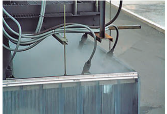
Control de emisiones en carga de camión mediante niebla seca
