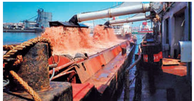
Las escorrentías directas sin tratamiento reducen la calidad de los sedimentos pudiendo encarecer las tareas de dragado
