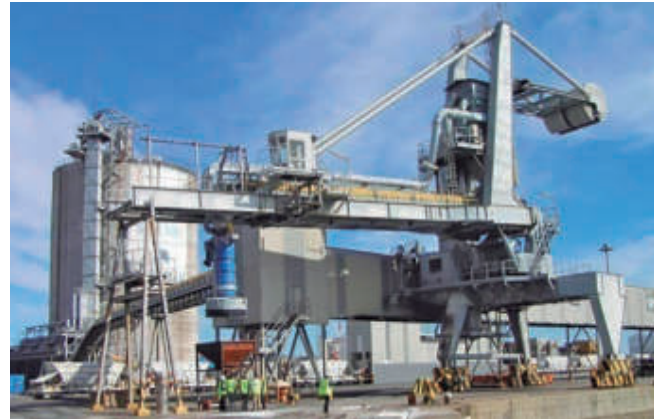
Cargador continuo con manga telescópica en muelle de uso común.
