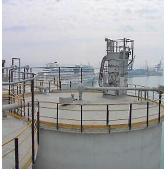
Sistema de aspiración en parte superior del silo para filtrar el aire saliente en el proceso de carga.
