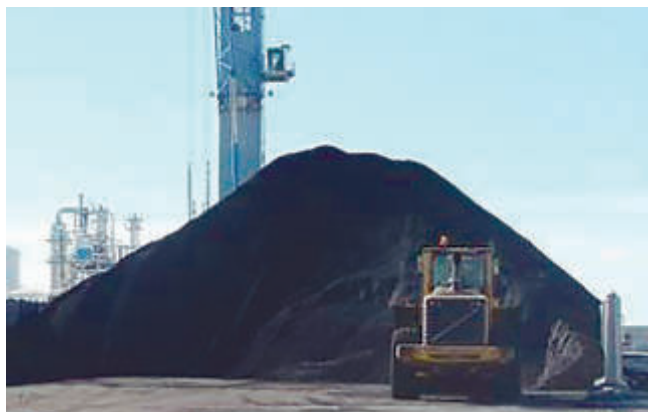
Separación de acopio y de zona de tránsito mediante muro móvil.
