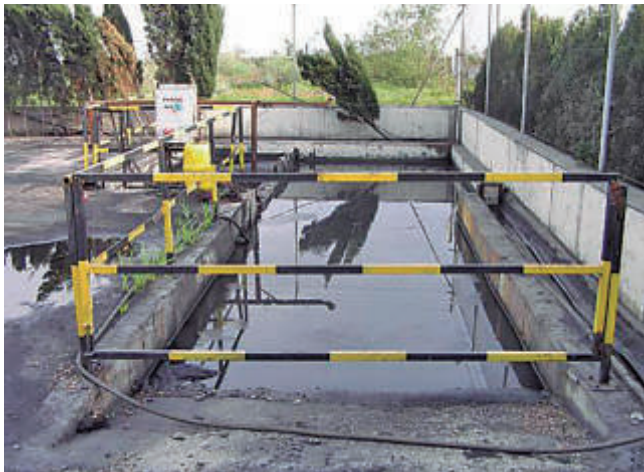
Decantación de escorrentías de aguas pluviales y de riego.
