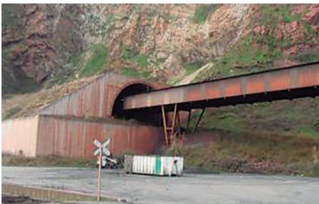
Las cintas transportadoras pueden conectar el puerto con instalaciones próximas fuera del dominio público portuario
