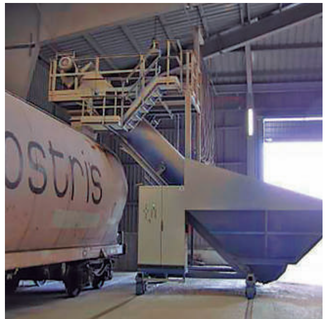
Cargadero de vagones en almacén mediante pala y elevador móvil.
