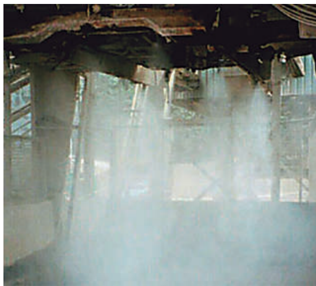
Control de emisiones de polvo en cargadero con inyectores de agua nebulizada.
