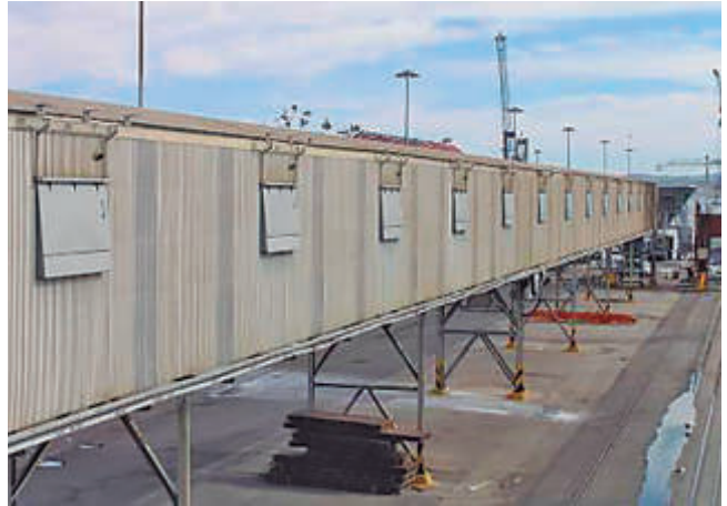
Cinta paralela al muelle protegida por una galería con ventanas para conectar cargador continuo de barcos
