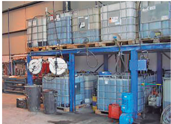
Clasificación de residuos peligrosos procedentes de mantenimiento.
