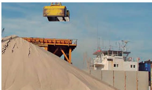
Delimitación de acopios mediante muros móviles.
