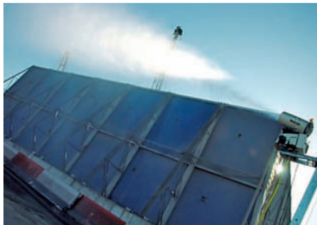
Turbina de agua atomizada mejorando la acción de una pantalla atrapa polvo.
