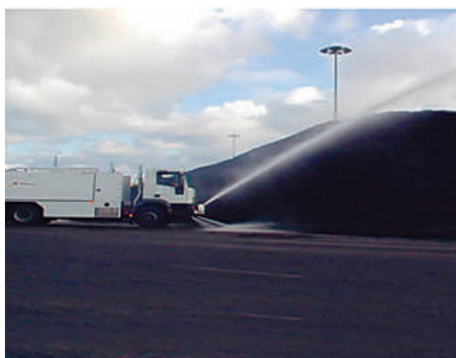
Aspersión con camión cisterna
