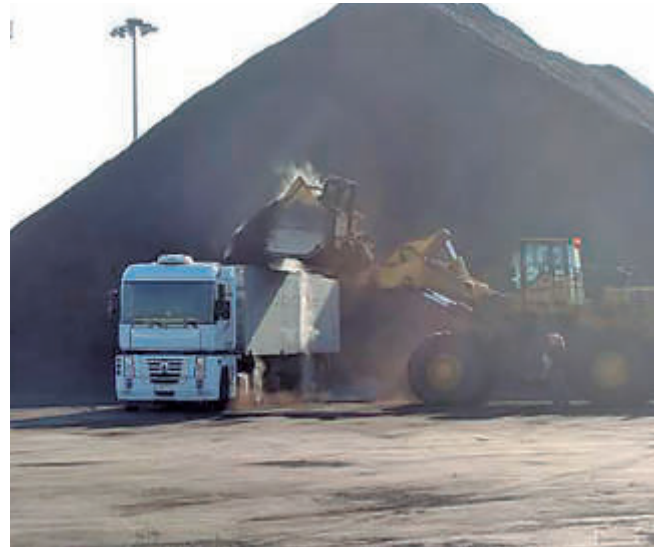
Los cazos de las palas y las cucharas de las grúas pueden producir ruidos en impactos contra camiones, suelo, tolvas y buques.
