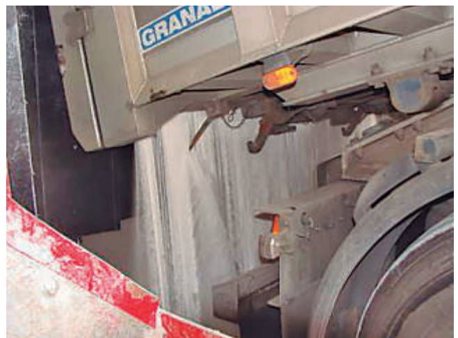
Descarga de camion en tolva con aspiración forzada.
