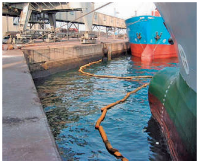
Un mantenimiento adecuado previene roturas y vertidos de aceites a la dársena.
