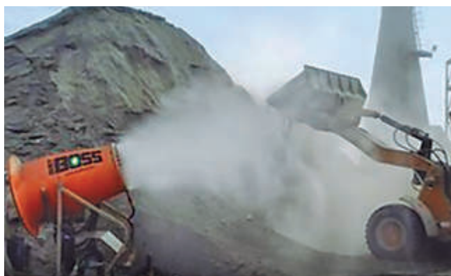
Control de emisiones de polvo con cañón atomizador.
