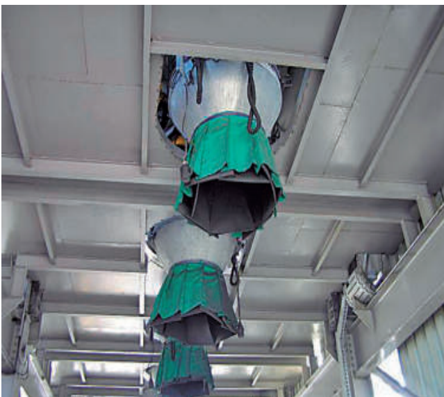
Cargadero con varias mangas evita la necesidad de mover el camión durante la carga
