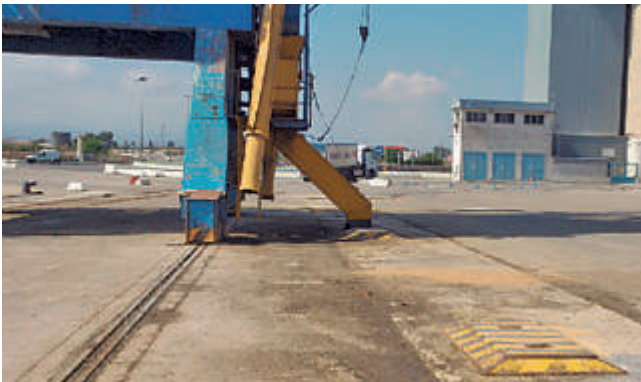
Descargador alimentando una cinta en galería subterránea.
