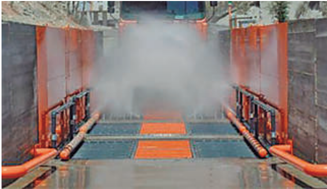
Limpieza de ruedas y bajos a la salida de la terminal de carga
