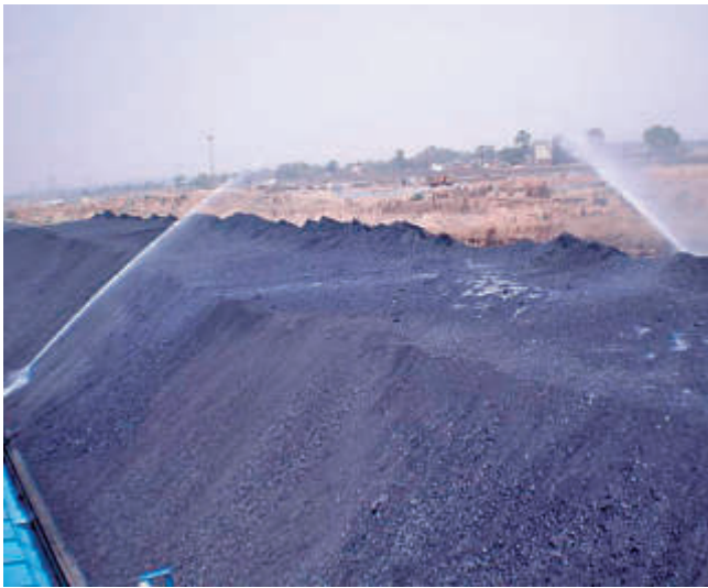
Red de drenaje perimetral superficial en torno a acopio estabilizado por red de aspersión.
