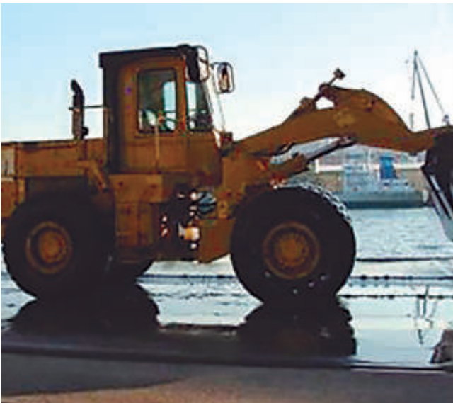
La limpieza, mantenimiento o repostado de equipos, en lugares no adecuados puede generar vertidos contaminantes.
