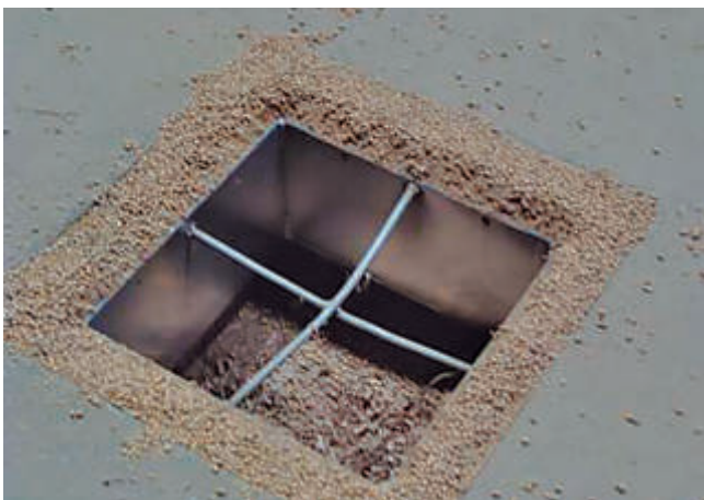
Descarga de almacén mediante tolva subterránea y cinta de evacuación subterránea en almacén de cereales
