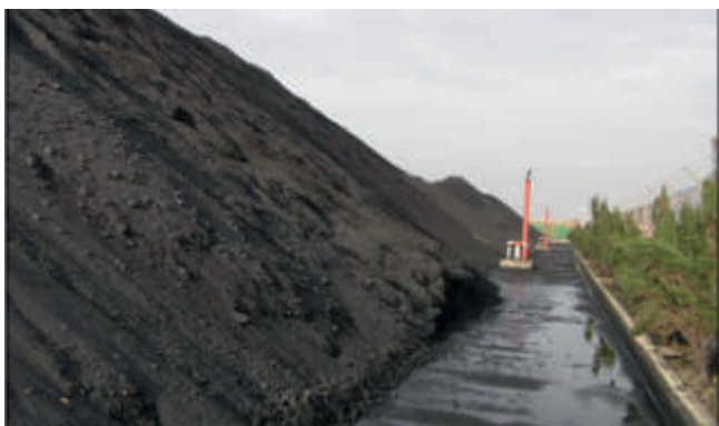
Parque de graneles con sistema de riego y recogida perimetral del agua de riego
