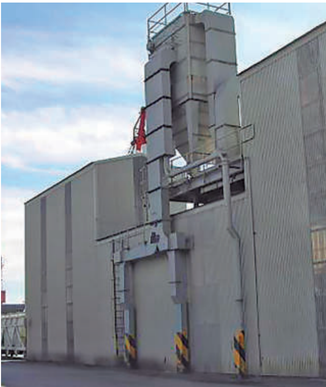
Descargador de vagones cubierto con tolva subterránea con aspiración.
