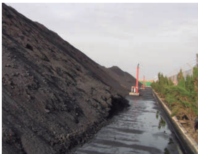
Aspersión con cañones de agua fijos.
