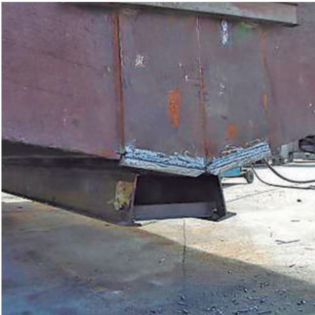
Tareas de mantenimiento. Sustitución de la cuchilla en una cuchara.
