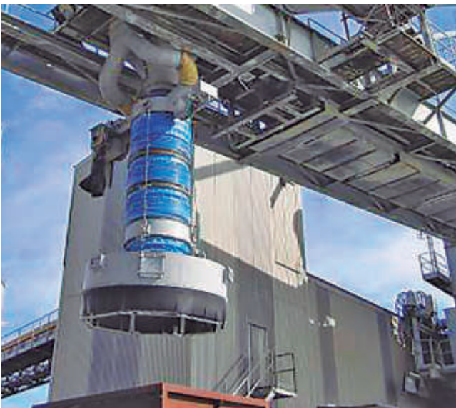
Cargador de cemento con tolva telescópica con aspiración concéntrica
