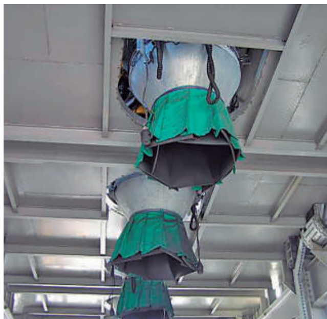
Mangas telescópicas de descarga. Las tres mangas permiten un llenado uniforme de la caja sin necesidad de mover el camión.
