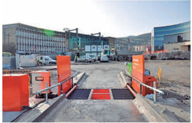
Lavaruedas con balsa de decantación somera y sistema de recogida de lodos
