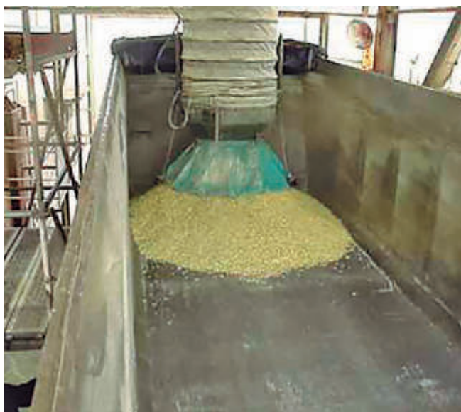
Control de emisiones de polvo en cargadero de camiones con tolva telescópica de cascada.
