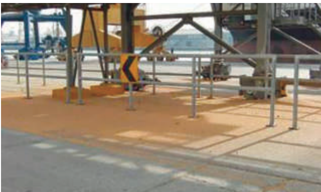
Si no se realiza un raspado adecuado de la cinta la mercancía adherida cae en el retorno de la cinta
