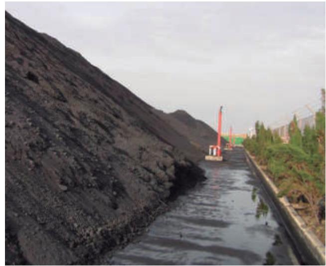
Cañones rodeando el acopio permite buena cobertura en todas las condiciones de viento.
