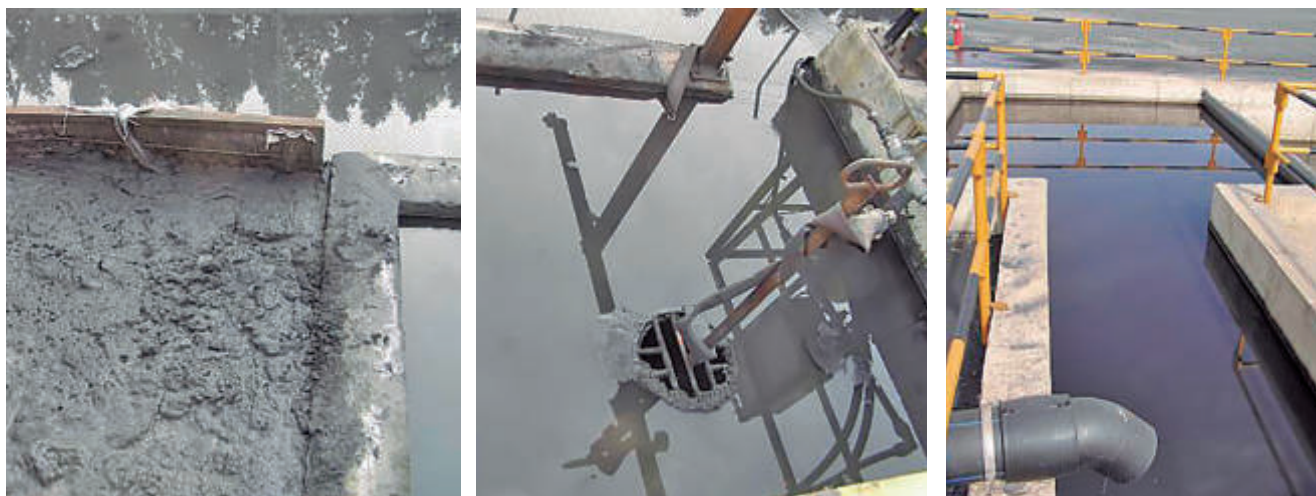
Decantación mediante floculantes y retirada de flotantes (izquierda y centro). Balsa de decantación secundaria (derecha)
