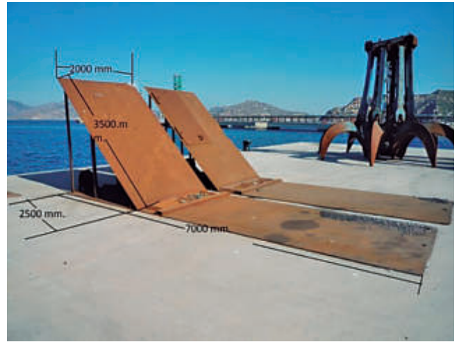
Detalles constructivos de rampas atrapa derrames
