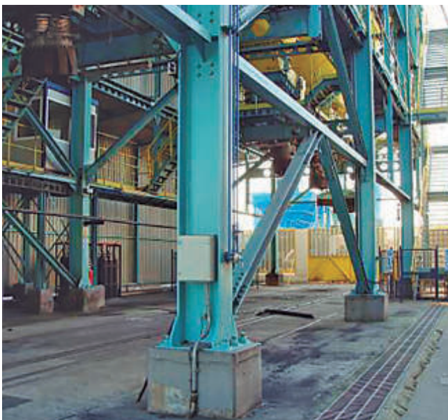
Cargador con dosificador de carga, y varias mangas de carga con aspiración por vagón.
