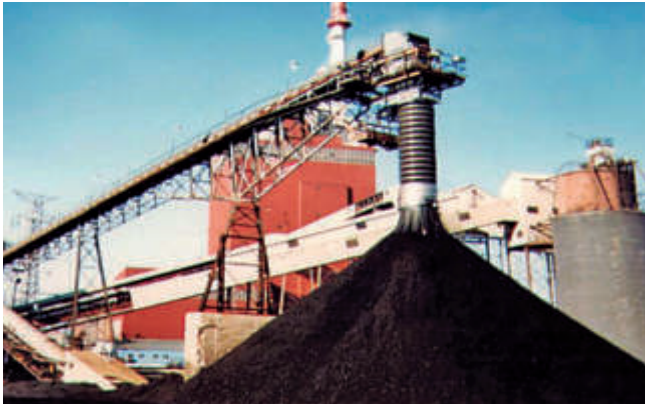
Formación de acopio mediante tolva telescópica cubierta.
