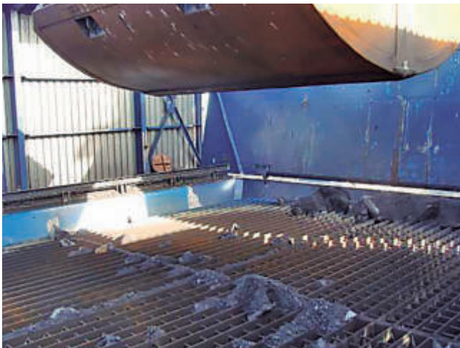
Descarga de cuchara, sobre tolva en grúa pórtico, apantallada para limitar el efecto de arrastre del viento.
