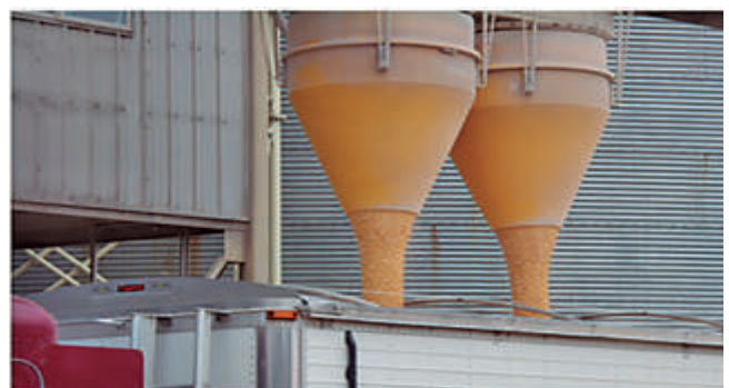
Cargadero de camiones.
