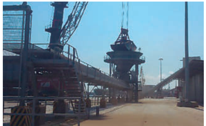
Descarga con cuchara a tolva con cinta
