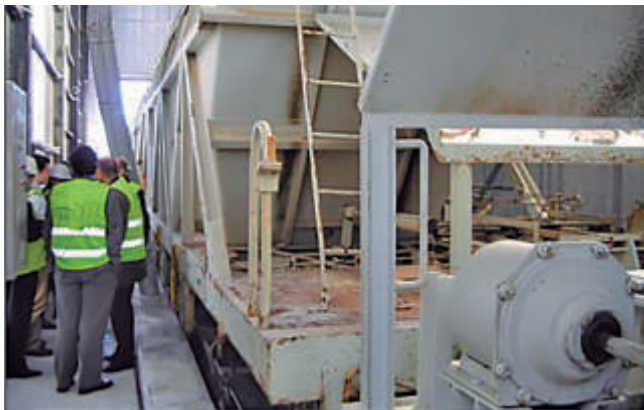
Descarga de vagones sobre tolva subterránea con aspiración en recinto cubierto.
