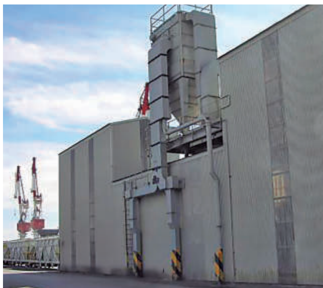
Descargadero de vagones dotado de aspiración en tolva de descarga
