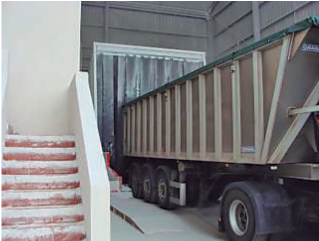
Zona de descarga de camiones apantallada.
