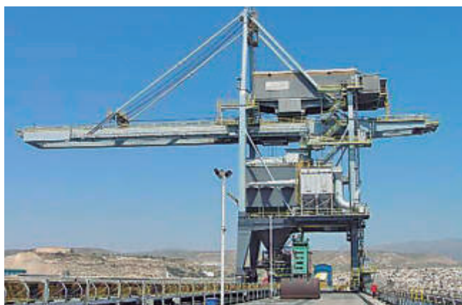
Descarga con grúa pórtico (sistema discontinuo) y movimiento horizontal mediante cinta (sistema continuo)
