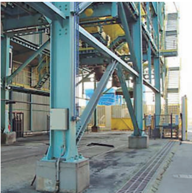
Cargadero de vagones mediante tolva telescópica.
