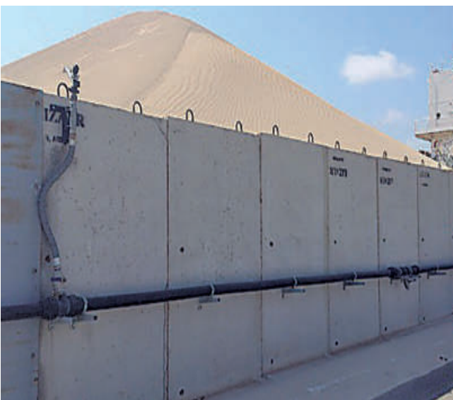
"Muro móvil" acotando acopio en primera línea con sistema de pulverización de agua.
