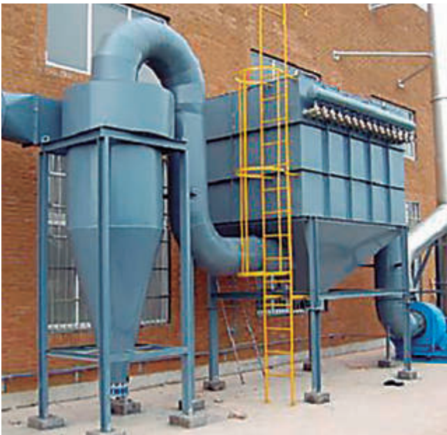
Prefiltrado mediante ciclón.
