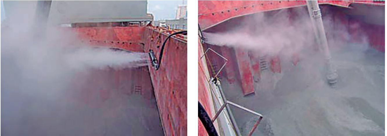
Sistema de niebla seca actuando en la bodega de un buque descargado con tornillo sin fin.
