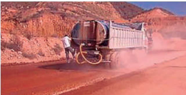
Pulverización de agua con aditivos selladores sobre campa no pavimentada.
