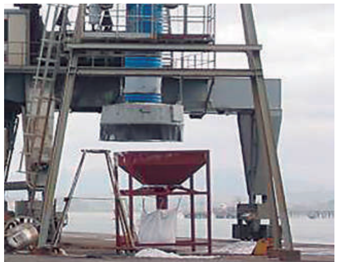
Limpieza de tolva telescópica sobre big-bag para evitar derrames.
