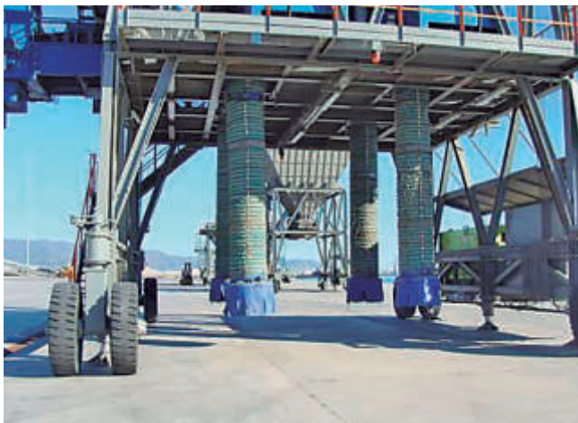
Mangas telescópicas con aspiración en carga de camiones desde tolva.
