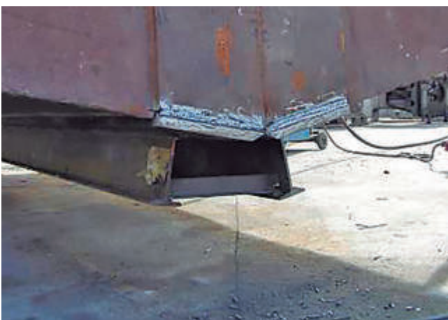
Reposición de cuchillas deterioradas en la base de la cuchara.
