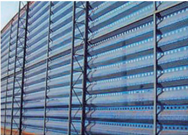
Pantalla cortavientos porosa sobre estructura tubular (izquierda) y detalle de las planchas perforadas utilizadas (derecha)
