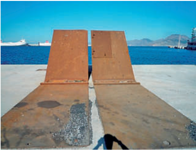
Detalles constructivos de rampas atrapa derrames
