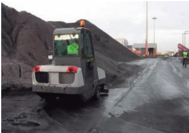
Limpeza de viales mediante barredora con aspiración.
