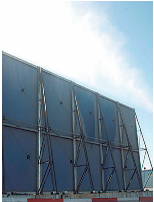
Descarga a primera línea protegida por pantalla atrapa polvo y cañones atomizadores.
