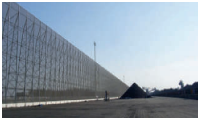
Parque de graneles protegido por barrera cortavientos.
