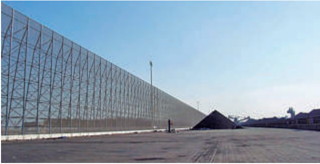
Pantallas corta-vientos en zona de acopio.
