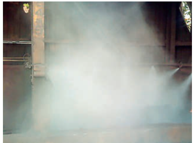
Zonas de descarga de vagones y camiones apantalladas, con atomizadores.
