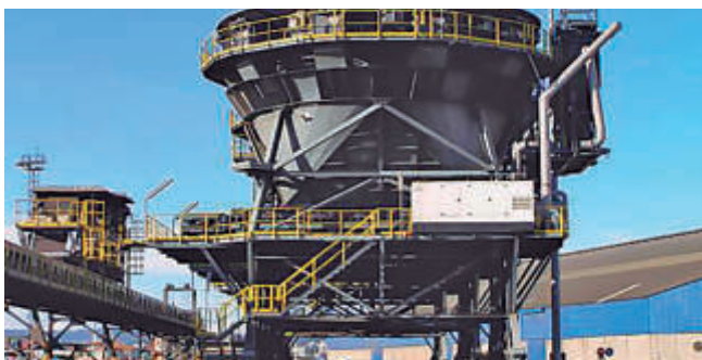
Tolva "ecológica" con sistema de aspiración en la corona y en la transferencia a cinta.
