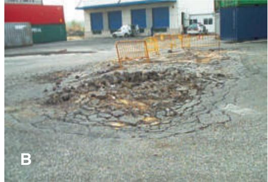
Ejemplos de daños que podrían calificarse como Ruinosos (R): A. Viga de un pantalán. B. Pavimento de un puerto.
