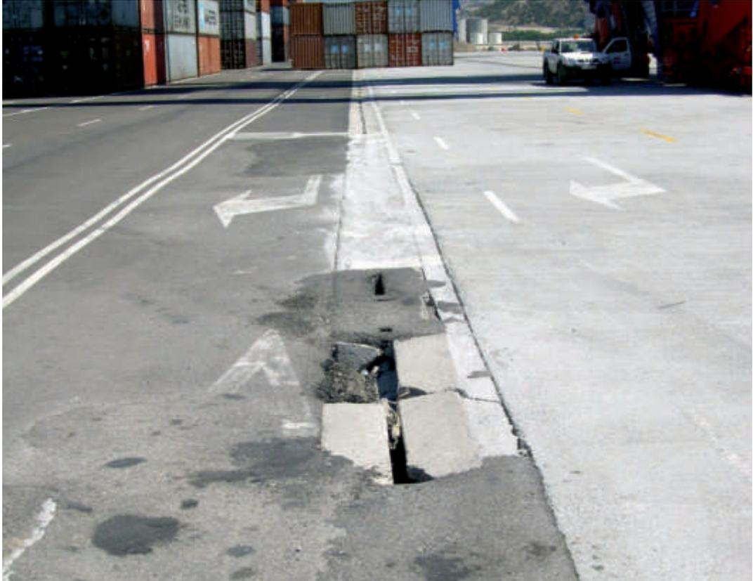
*Rotura de un elemento de drenaje.*
