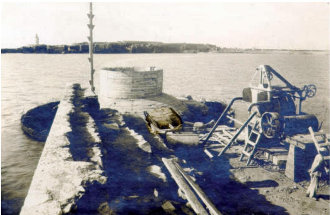
*Figuras 22 y 23. Traslado y fondeo de elemento singular que define la infraestructura del morro del dique.*
