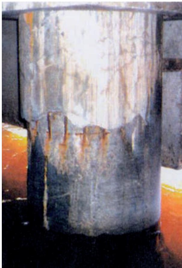
*Corrosión de armadura de un pilote.*
