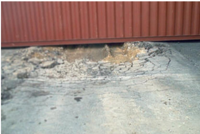
Ejemplos de daños un pavimento que condiciona su utilización con alguna restricción (calificación: 2)
