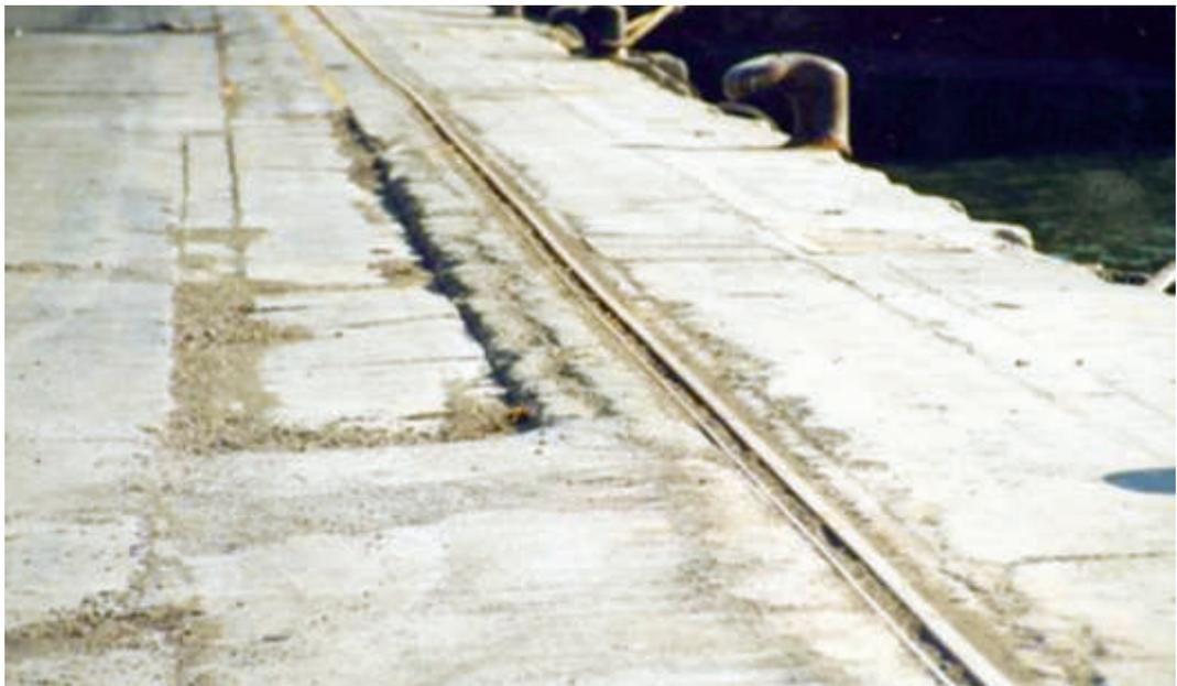
*Fisuración de pavimento.*
