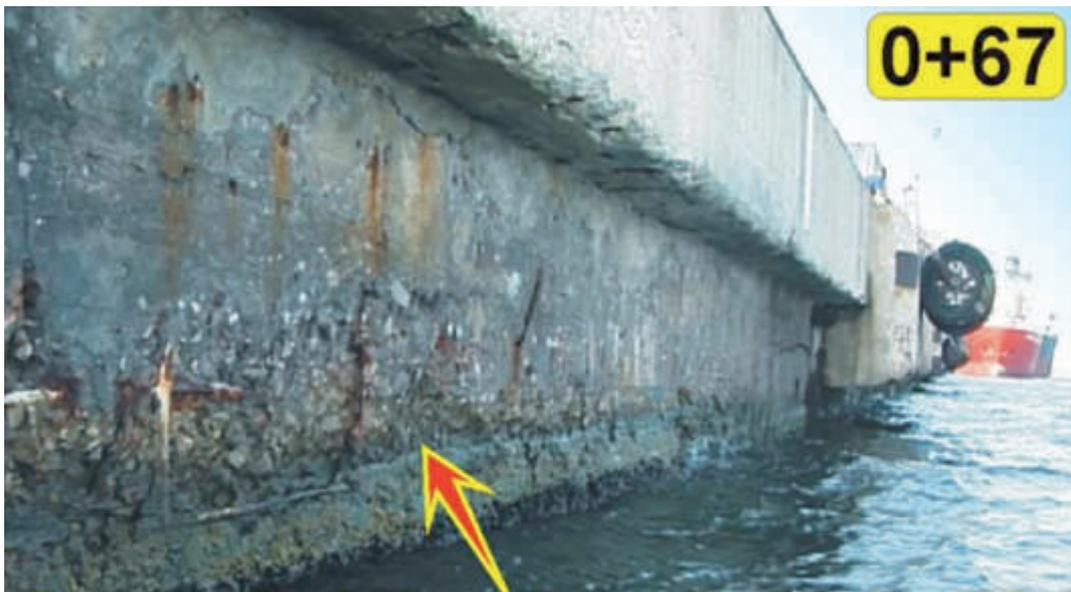
*Corrosión de la armadura del cajón.*
