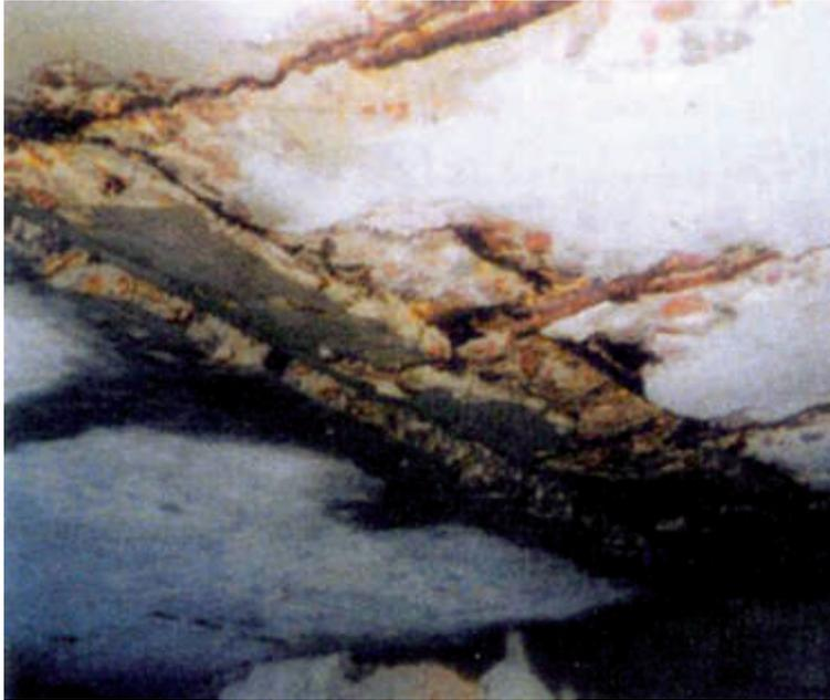
*Corrosión de armadura de una losa superior en muelle.*
