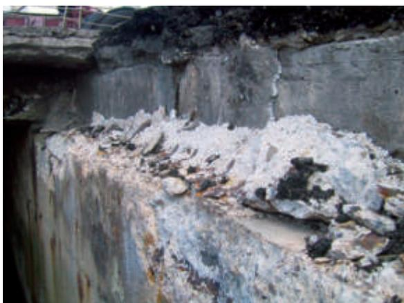
Ejemplos de daños por corrosión en cara inferior de un pantalán cuya trascendencia estructural lo califica como *fuera de uso* (calificación: 3).
