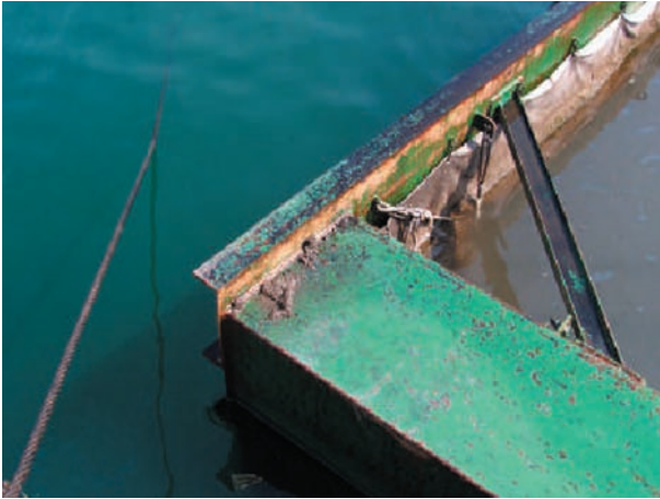
Estado del agua dentro y fuera de la celda de geotextil.
