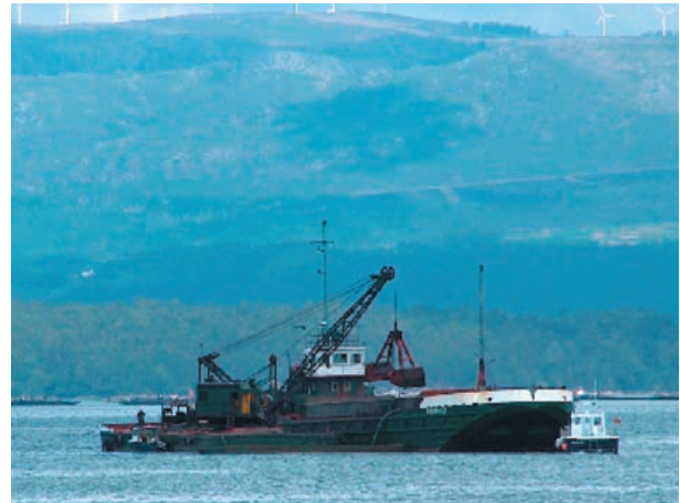
Entorno de la zona de Dragado.
