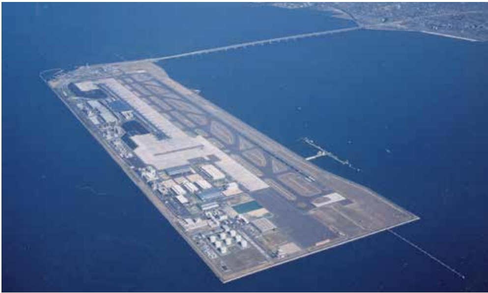
El Aeropuerto Internacional de Kansai en Japón está ubicado en una isla artificial realizada mediante dragado.
