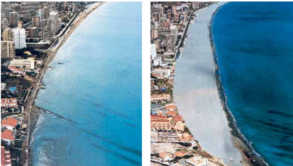
Alicante, España, antes y después de la regeneración de la playa: Dragado para reparar playas erosionadas y costas dañadas.
