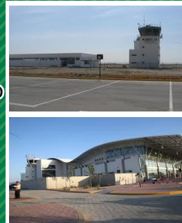
Aeropuerto de Pisco
