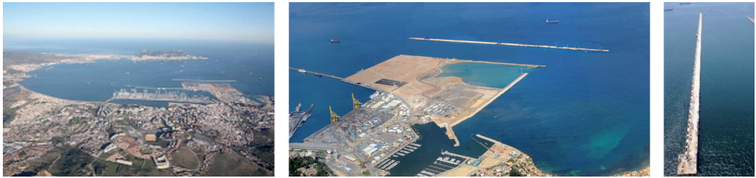
Figura 17. Ampliación del puerto de Algeciras en Isla Verde. Vista general y dique.
