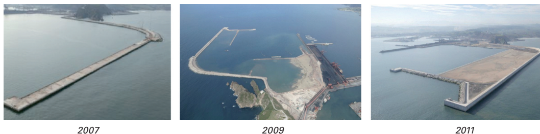
Figura 11. Estado de las obras.
