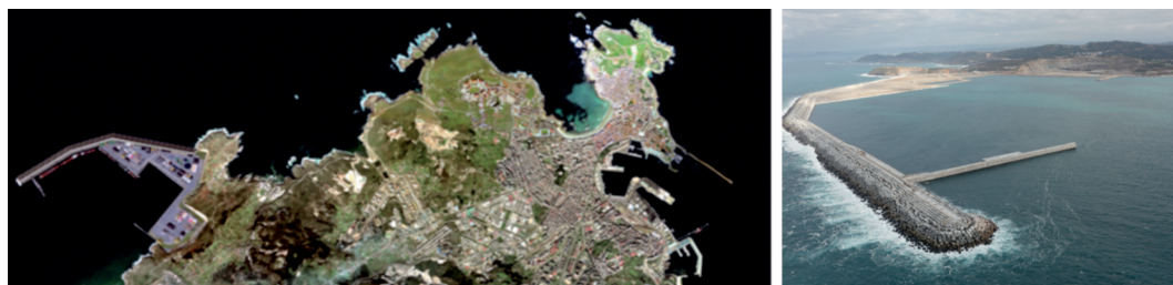
Figura 12. Emplazamiento y dique construido (enero 2012).
