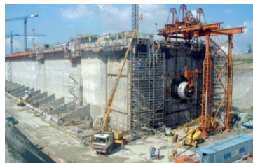
Dique seco puerto Algeciras (España)
