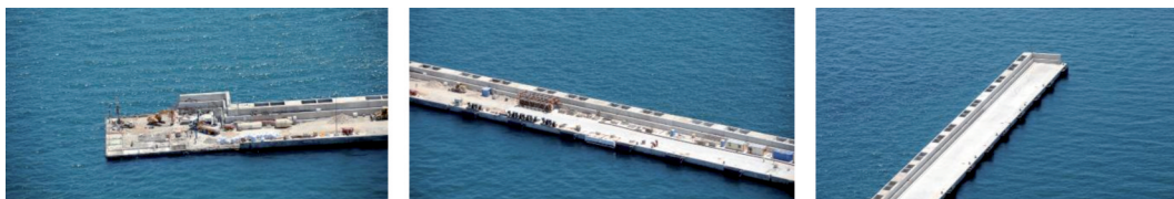
Figura 20. Situación de la obra en 2006 y finalizada (2008).
