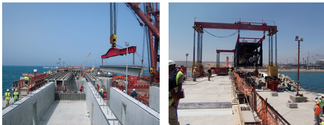
Figura 17. Superestructura en el puente de acceso: soportes de la vía de acceso y montaje del poliducto desde la misma.
