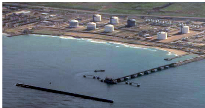
Figura 18. Vista general del proyecto con la superestructura ejecutada.
