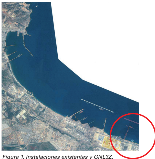
Figura 1. Instalaciones existentes y GNL3Z.
