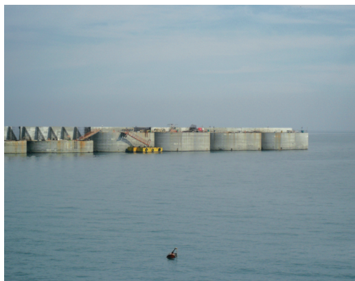
Figura 22. Muro de coronación en el dique. Sección sencilla y sección con contrafuertes
