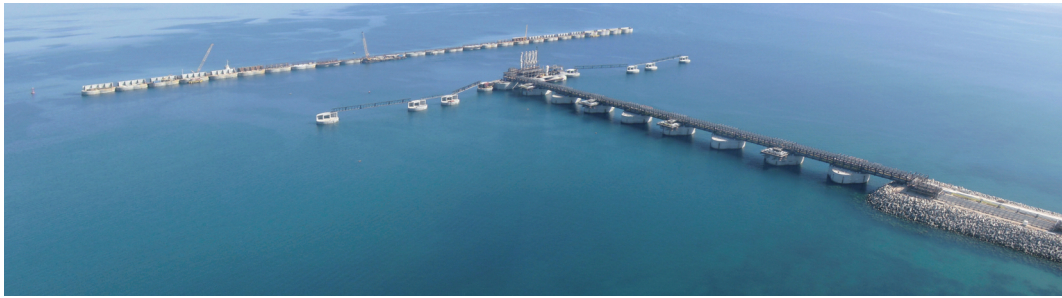
Figura 4. Vista general de la instalación marítima del proyecto en fase de ejecución del espaldón.
