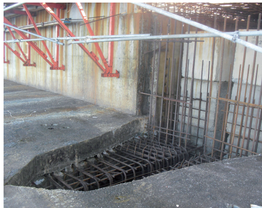
Figura 24. Detalle de la fase de ejecución de la junta entre cajones.
