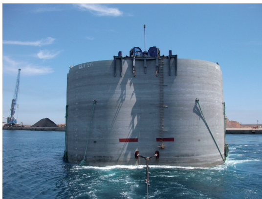
Figura 13. Partida de un cajón del dique hacia Argelia. Figura 14. Situación del punto de datos para análisis.
