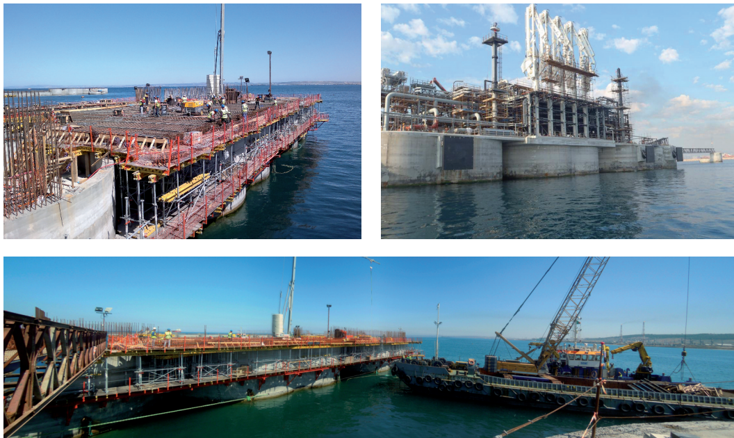
Figura 5. Encofrado colgante para ejecución de la losa en voladizo de la plataforma de carga y estado final.
