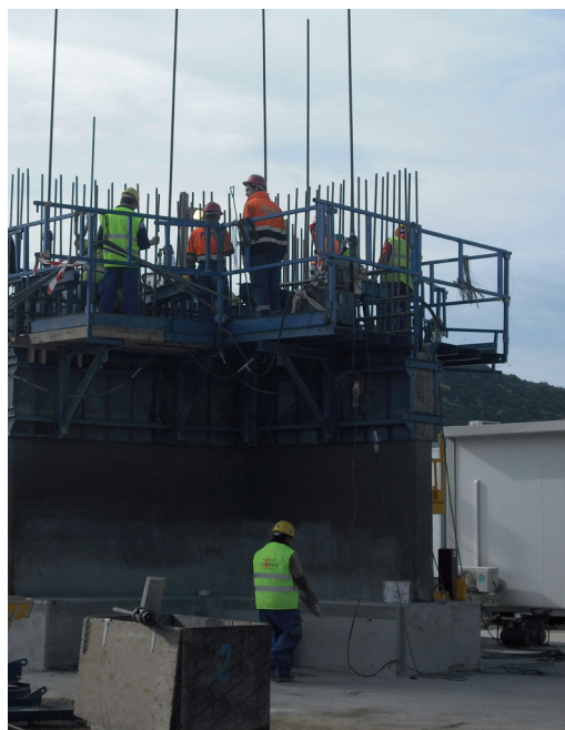
Figura 11. Ejecución de la prueba de deslizado y tratamiento superficial.
