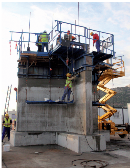
Figura 11. Ejecución de la prueba de deslizado y tratamiento superficial.
