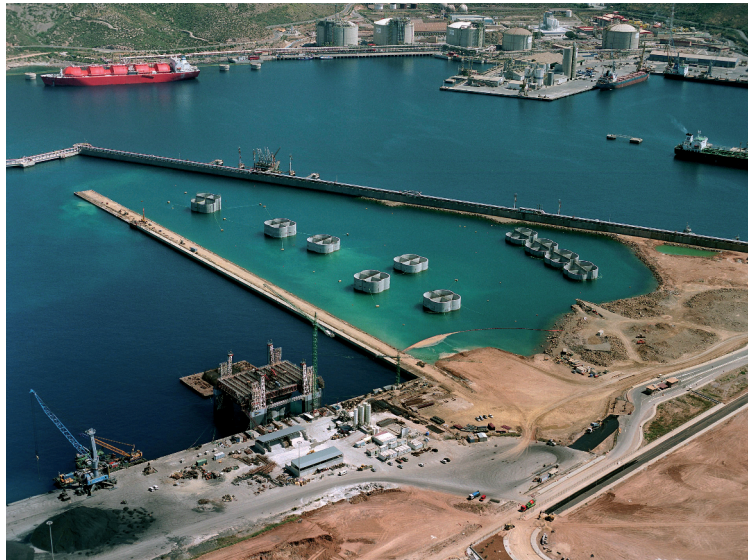
Figura 12. Vista general de la implantación de la planta de prefabricación.
