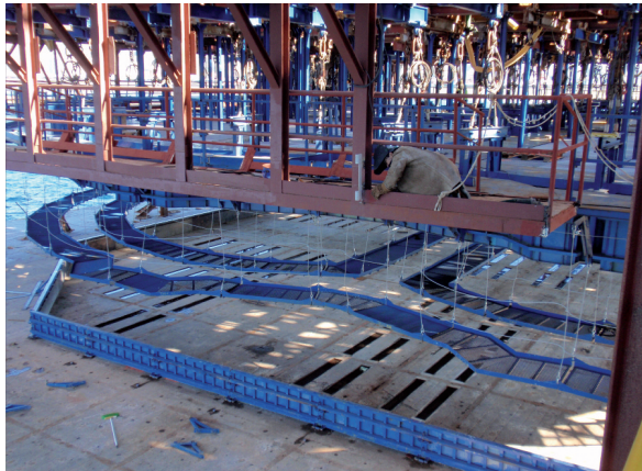
Figura 10. Encofrado especial y diseñado según criterios de la industria del Gas y Petróleo.
