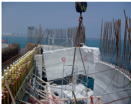
Figura 20. Plataforma de carga. Fase de ejecución de la losa y demolición de paredes para los macizos de las defensas.
