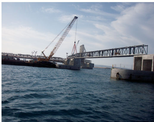
Figura 21. Montaje de las pasarelas y equipos en la plataforma de carga.
