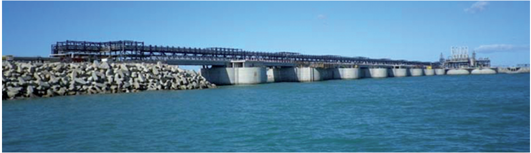
Figura 6. Puente de acceso de acceso con instalaciones completadas.
