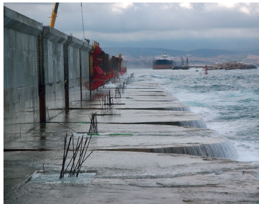
Figura 23. Vista desde lado mar del dique.
