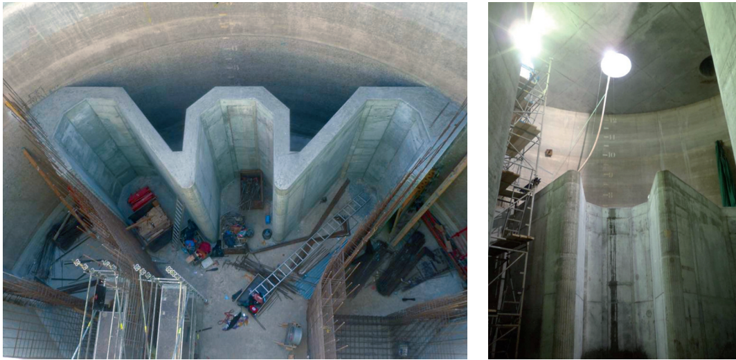
Figura 19. Vista interior de la casa de bombas.
