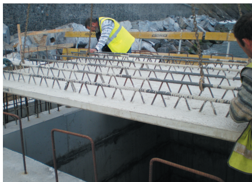
Figura 21. Disposición del encofrado perdido.
