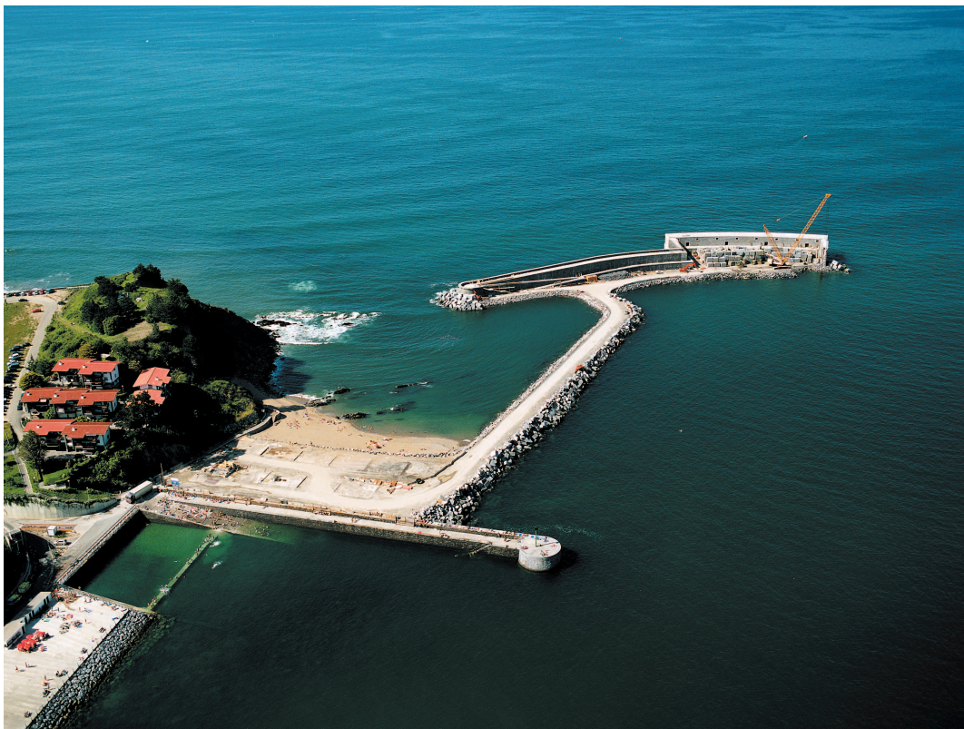
Figura 24. Situación de la obra a junio de 2008.
