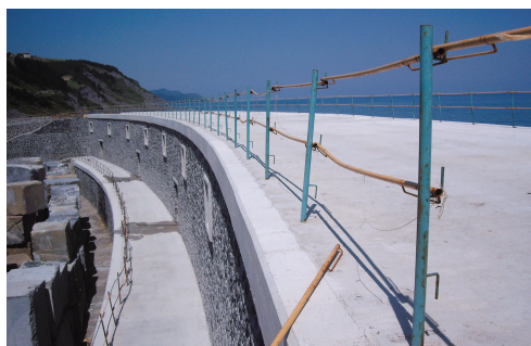
Figura 23. Vista exterior de la galería con mampostería e imposta.
