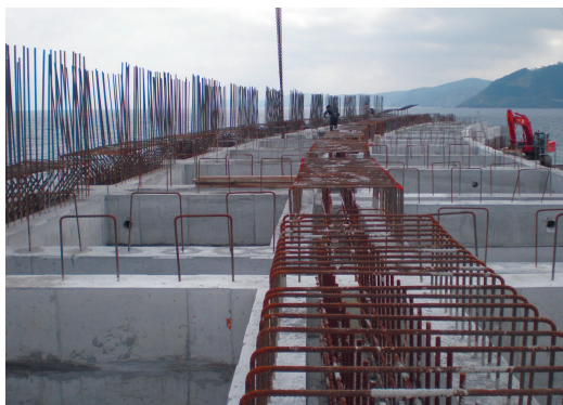
Figura 20. Columnas previo al cierre.
