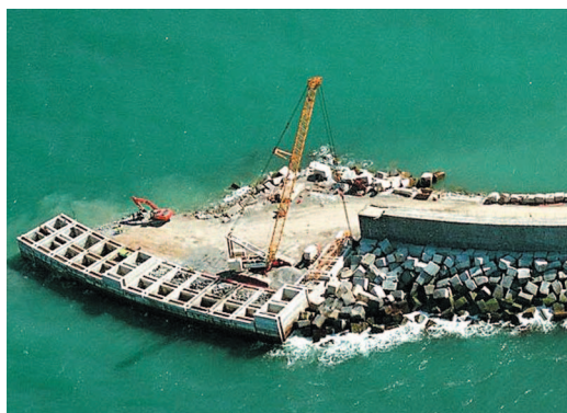
Figura 19. Central y dique unidas.
