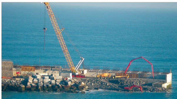
Figura 22. Diferentes momentos de la ejecución de la galería de las turbinas.
