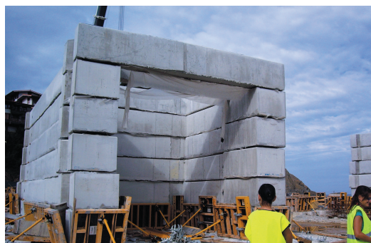
Figura 16. Acopio de piezas.
