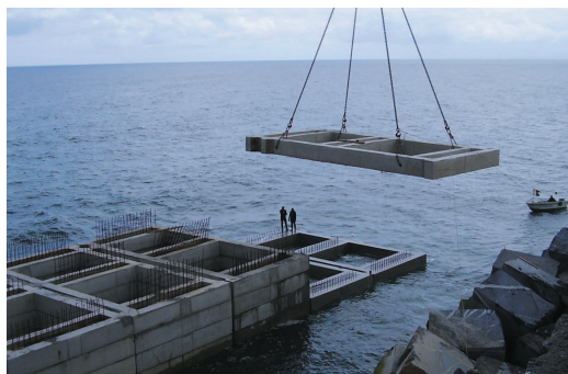
Figura 17. Colocación de las piezas.
