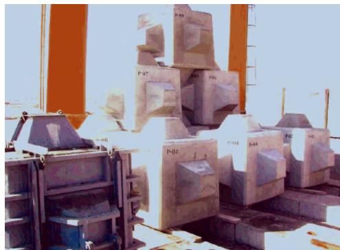
Figura 9. Encofrado y almacenamiento de cubípodos.
