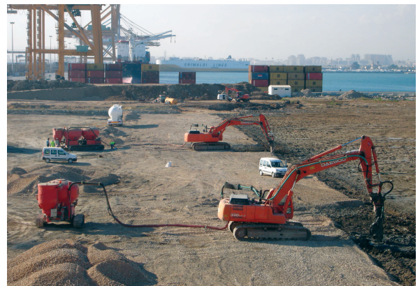
Ilustración 3. Ejecución costra suelo-cemento.
