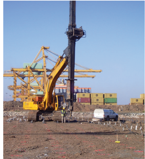
Ilustración 4. Máquina hincando drenes.
