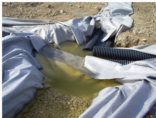
Ilustración 6. Zanjas y pozos drenantes.
