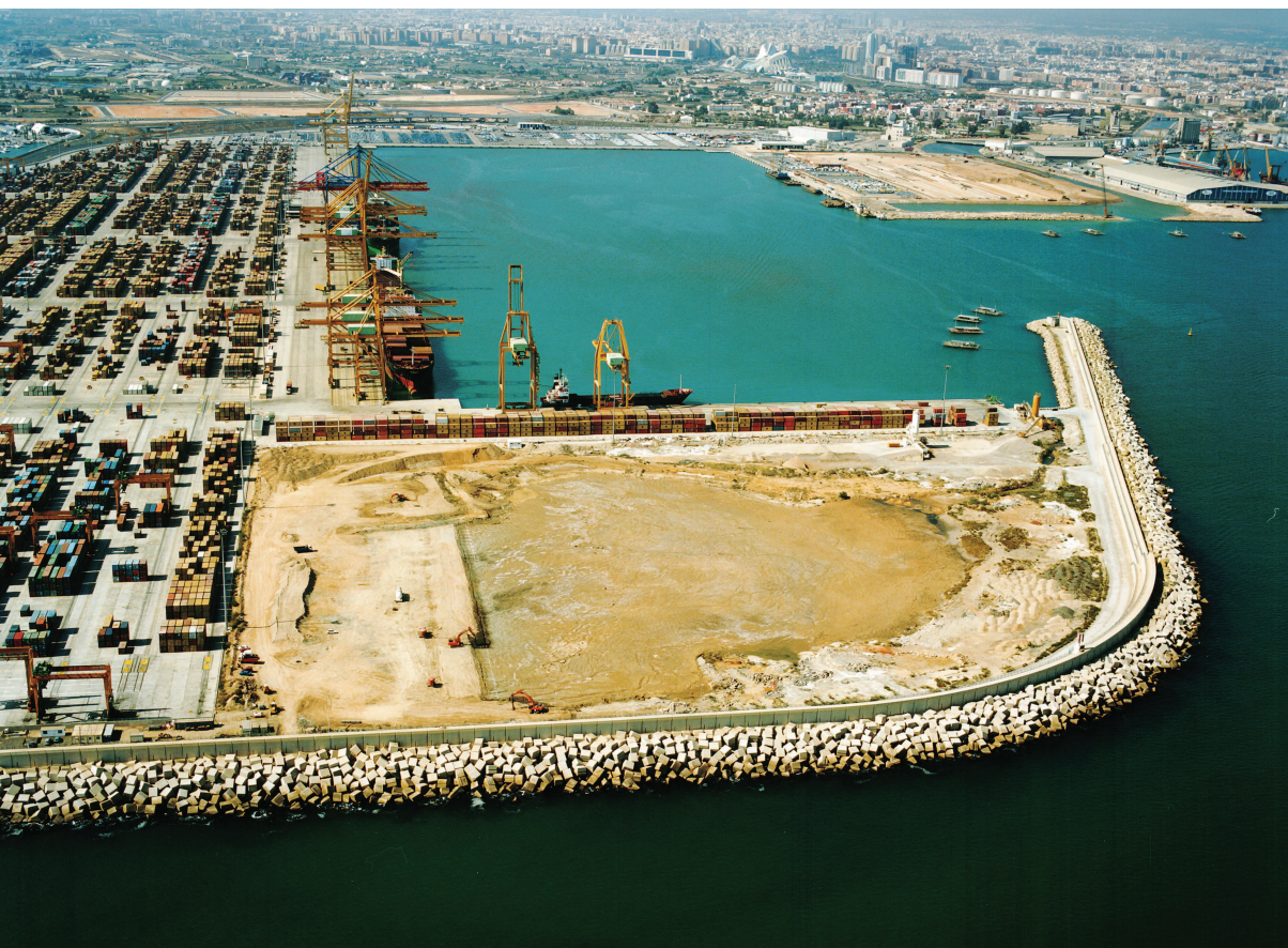
Ilustración 1. Estado de las obras en octubre de 2005.
