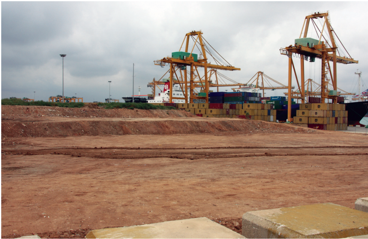
Ilustración 9. Retira de la precarga en dos escalones.
